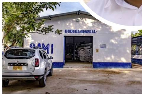
Lagergebäude auf der Farm Sami
